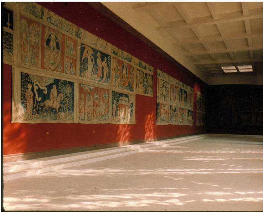
Figura 11.- Interior de las galerías del apocalipsis. Lucernario, estructura y celosías en cuartos ortogonales
