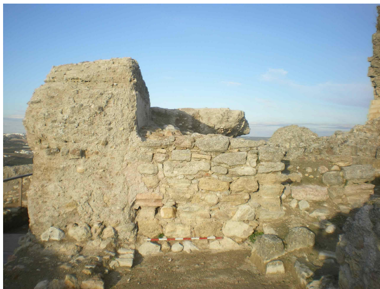
Figura 4. Ejemplo del estado de conservación del sillarejo.
